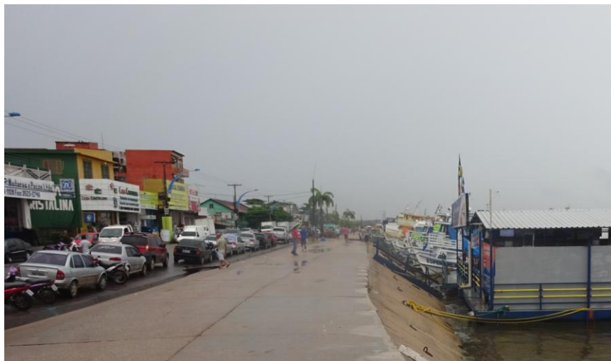
Fotografia 22 - Vista lateral do terminal de passageiros Tapajós e da rua de acesso.
