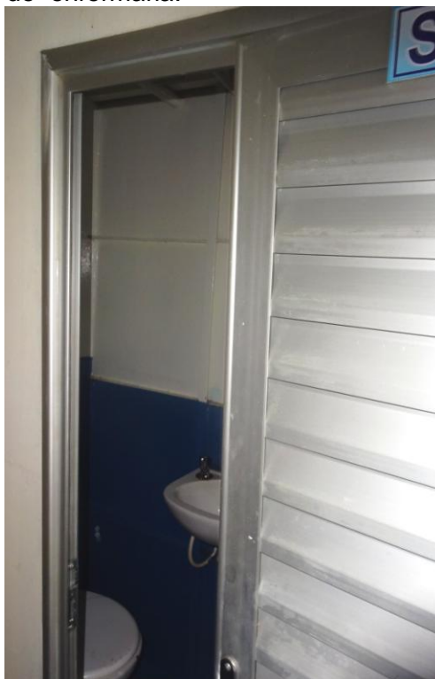
Fotografia 12 - Banheiro do camarote de enfermaria.
