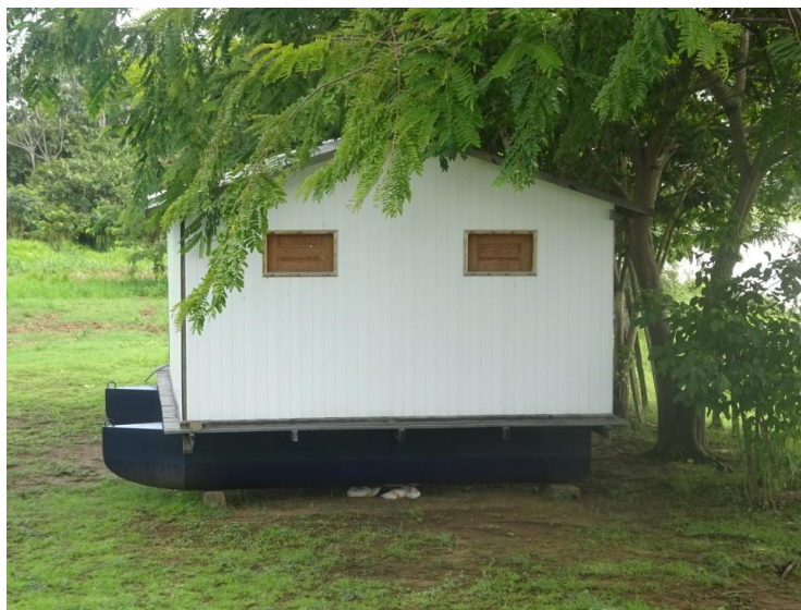
Fotografia 4 - Casa flutuante feita com estrutura de alumínio.
